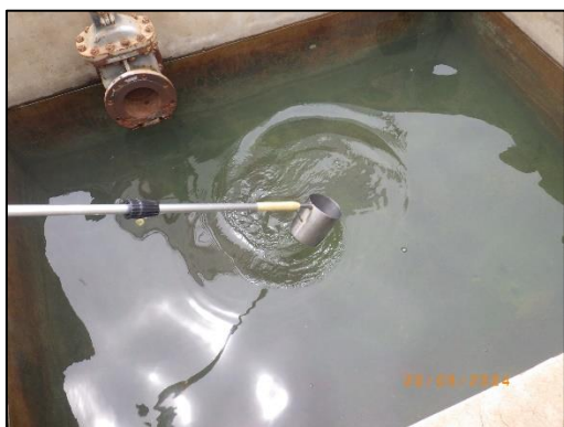
บ่อ (API) ที่เก็บกักน้ำฝนที่ตกบนท่าเรือ
